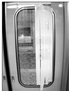
応急処理後の状態
